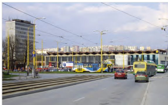
Stacja kolejowa Koszyce (źródło: IU / Martin Reents)
