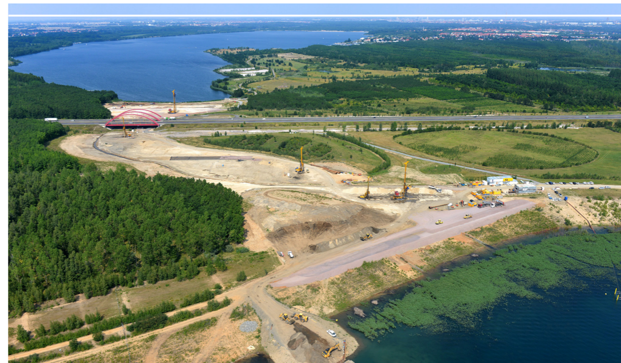
Foto 2.2: Baustelle Harthkanal zwischen Zwenkauer und Cospudener See im Kreuzungsbereich mit der Autobahn A 38 (LMBV mbH/ Peter Radke)
