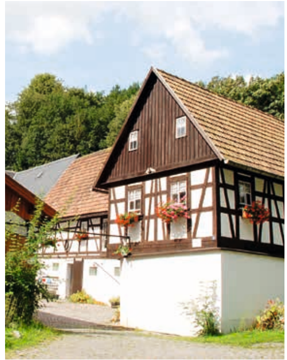
Niedermühle in Bräunsdorf
