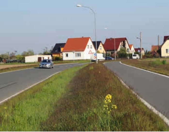
Ausbau der Ortslage Walda-Kleinhiemig (Kreisstraße 8570, 8582 und 8583) mit Neubau eines straßenbegleitenden Radweges (Gemeinschaftsmaßnahme Landkreis Meißen und Große Kreisstadt Großenhain)
