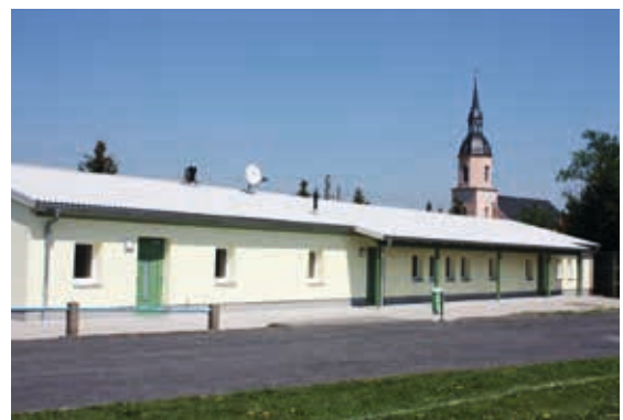
Saniertes Dorfgemeinschaftshaus im Ortsteil Bauda
